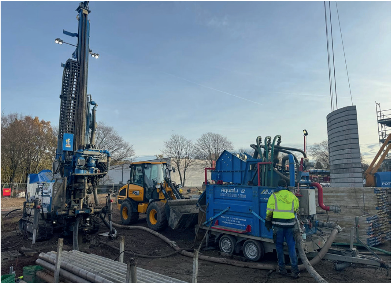
SpeedShaker H3 und Bohranlage sind einsatzbereit.
