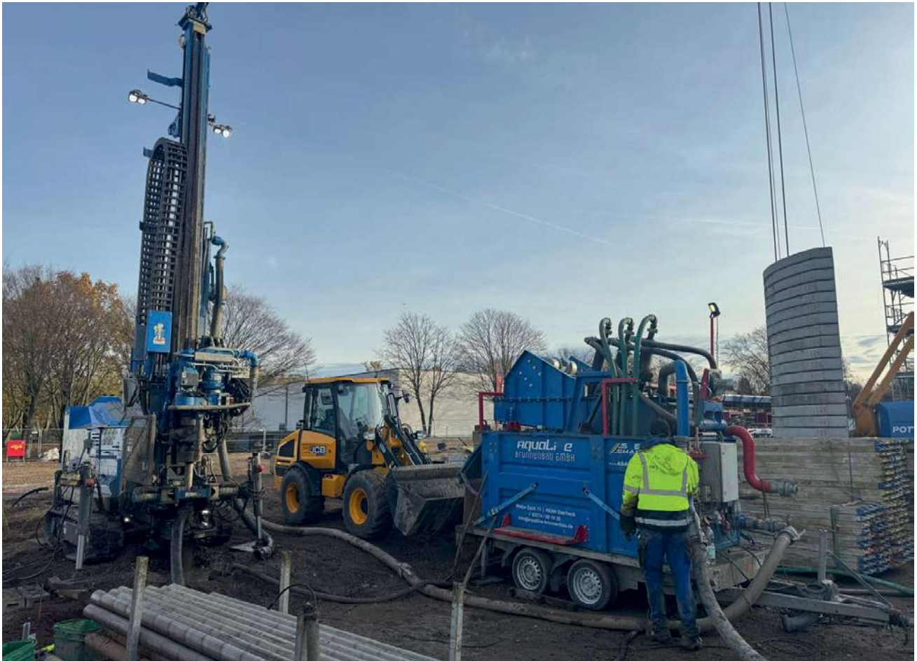
SpeedShaker H3 und Bohranlage sind einsatzbereit.
